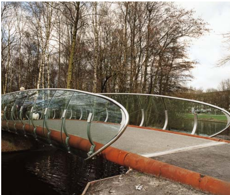
Brug in het Rembrandtpark, Amsterdam. Brugdekconstructie in weervast staal.
